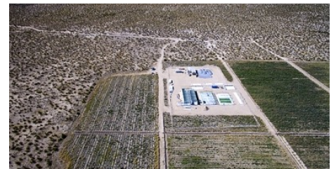
Comienzan las obras de la planta fotovoltaica Villanueva, la mayor del continente americano con 754 MW
